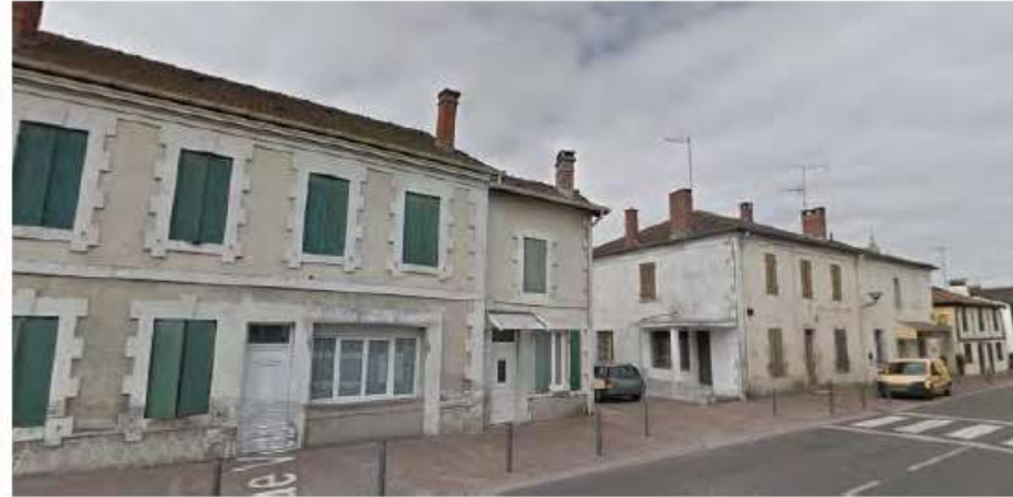
Habitat, patrimoine et rénovation énergétique, quel compromis?- 22 mai 2018
